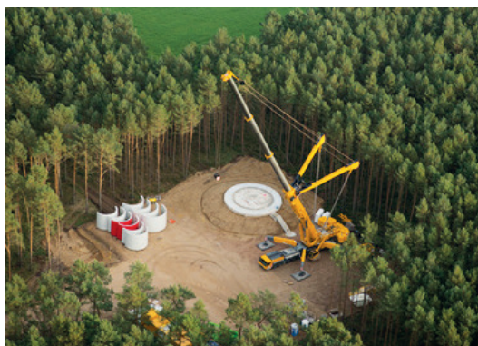
Afb. 2: Windturbines in bossen zijn nauwelijks opgemerkte veroorzakers van verhoogde nitraatwaarden. De vereiste kaalslag bevordert de uitspoeling van voedingsstoffen in het grondwater.
